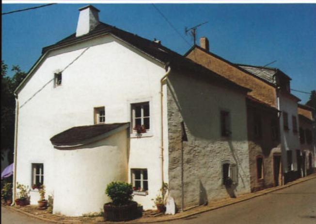
Der lothringische Einfluß dieses Hauses an der Saar zeigt sich an den schmalen, flachliegenden Fenstern über dem Obergeschoß, die zur Belichtung und Belüftung des Speichers dienen.
