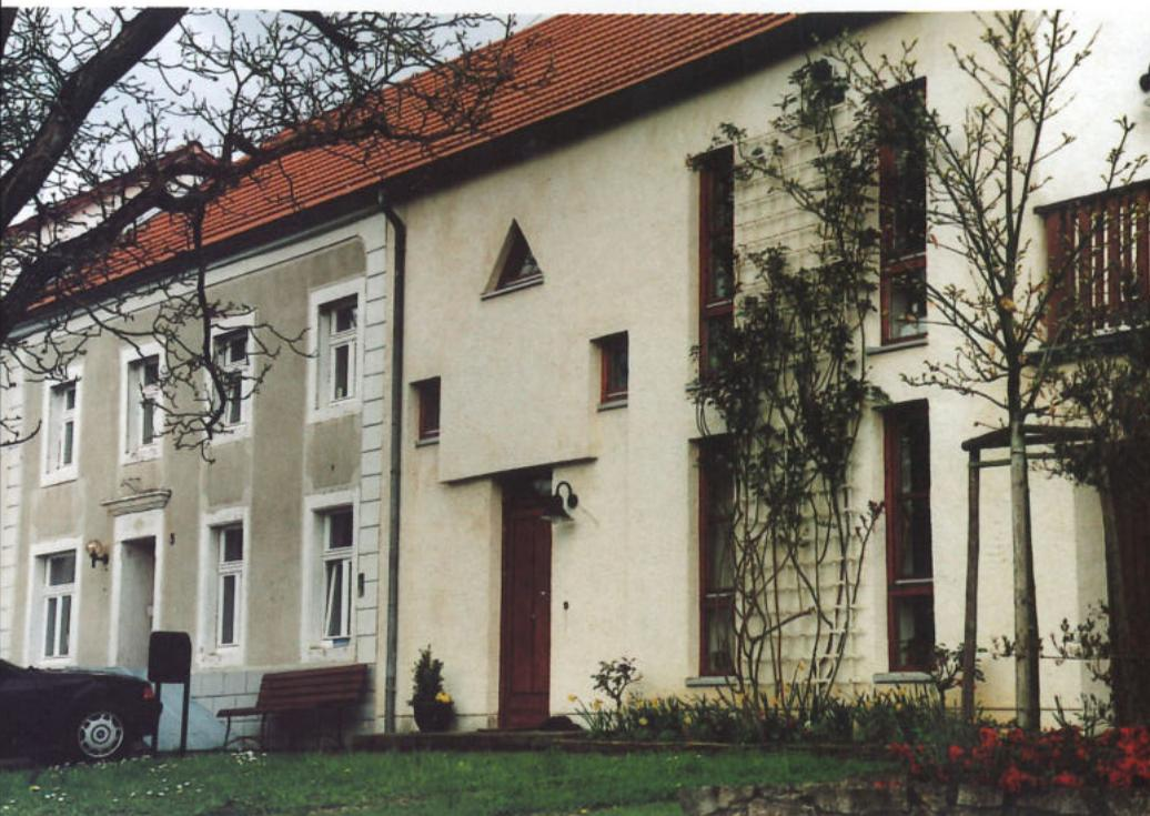
Die Ergänzung dieses traditionellen Hauses an der Sauer basiert auf einfachen Grundüberlegungen: Das Volumen des historischen Baukörpers wird exakt übernommen und weitergeführt. Die Dachfläche bleibt wie beim Altbau ungestört. Die Fassadengliederung greift die Öffnungsformen und Proportionen des alten Hauses auf und führt diese Ordnung in heutiger Architektursprache weiter.
