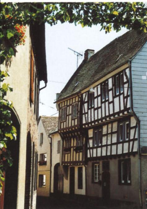
Feuchteschutz für die hölzernen Bauglieder ist eine wichtige Forderung für die Technik des Fachwerksbaus. In Höhe der Geschoßdecken springen daher die Außenwände zurück, so daß die jeweils darunterliegende Fläche vor Regen geschützt ist. Das erdgeschossige Schiefermauerwerk verhindert das Aufsteigen von Bodenfeuchtigkeit.
