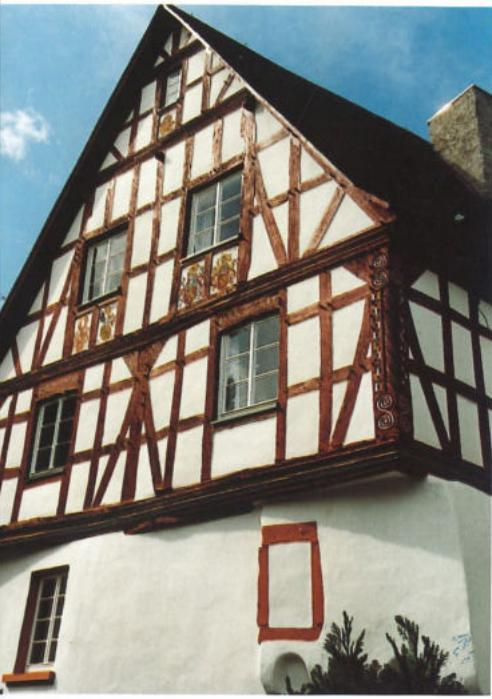
An Mittel- und Untermosel dominieren Fachwerkhäuser, deren Herkunft von Mittelalter bis ins 20. Jahrhundert reicht. Zu den gemeinsamen Merkmalen zählt die Kombination von massivem Unterbau und Fachwerkoberbau. Um Schäden durch aufsteigende Feuchte zu vermeiden, steht der Fachwerkteil auf einem aus Schieferbruchstein gemauerten Erdgeschoß, meist auf massivem Keller aufgeführt.
