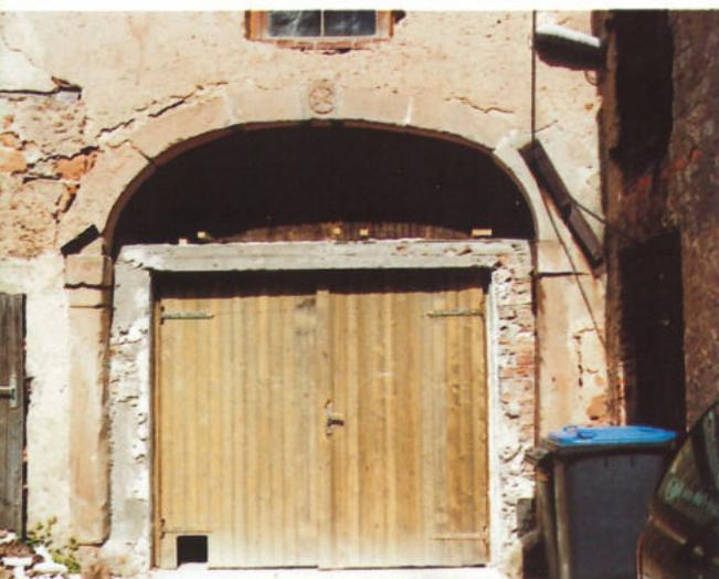
Offensichtlich fehlt hier Verständnis und Gespür für die Qualität der historischen Lösung. Mit dem für Mauerpfeiler und Betonsturz investierten Aufwand wäre die Reparatur des Holztores sicher möglich gewesen.
