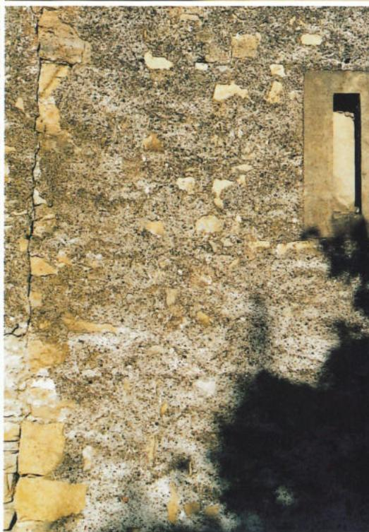
Die Farbwirkung nicht pigmentierter Putze wird bei den kalkgebunden Putzen vom Sandmaterial bestimmt. Je nach Gewinnungsort variiert der Farbton von Hell-gelbgrau an der Obermosel bis zu kräftigem Rot-ocker im Trierer- und Wittlichertal.
