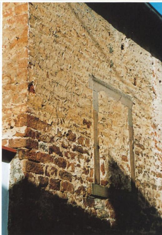
Die unterschiedliche Formsprache des Mauerwerks entsteht aus der Variation von Steinformat und Farbton.
