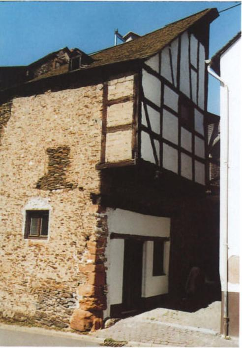
Besonders bei einfachen Beispielen zeigen sich konstruktive Prinzipien sehr klar: hier die leichte Fachwerkwand zwischen den schweren Mauerblöcken aus sorgfältig gefügtem Schieferbruchstein.
