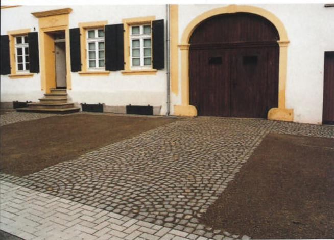
Natursteinpflaster auf den Geh- und Fahrwegen, dazwischen wassergebundene Decke. Beide Materialien werden ihrer Eignung entsprechend eingesetzt. Die Hausvorfläche ist funktionsgerecht und schön gestaltet. Dem höheren Kostenaufwand beim Pflaster steht ausgleichend der günstigere Preis der wassergebundene Decke gegenüber.
