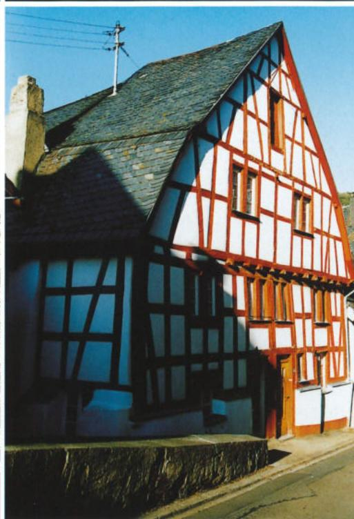
Immer werden die dünnwandigen und leichten Holzbauteile in der Kombination mit Mauerwerksblöcken eingesetzt. Das Mauerwerk bringt den Brand- und Feuchteschutz.
