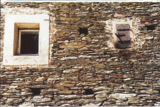
Bei den Mauerwerkflächen wird die Struktur durch Steingröße und Steinformat bestimmt.
