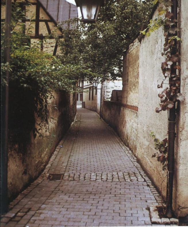
Betonsteinpflaster verlangt aufgrund seiner exakten Abmessungen eine dem Steinmaterial entsprechende präzise Verlegung in klar zugeschnittenen Flächen. Es wirkt dann peinlich, wenn versucht wird, altes Natursteinpflaster zu imitieren. Dieses Bild zeigt die Kombination mit Natursteinpflaster, wobei bei diesem Beispiel der Naturstein die Aufgabe übernimmt die unterschiedlichen Breiten der Wandanschlüsse zu überbrücken.
